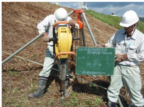
簡易ボーリングマシンによる掘削
