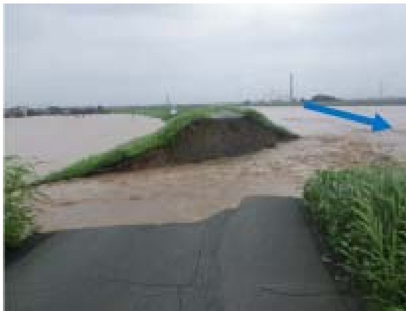
矢部川右岸7.3km破堤の状況(破堤後約2時間経過)
