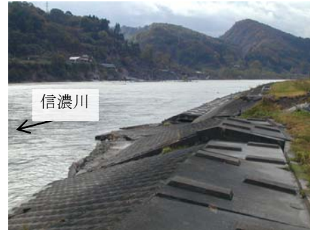
図-1 越の大橋付近の低水敷護岸変状(新潟県中越地震) 1)
