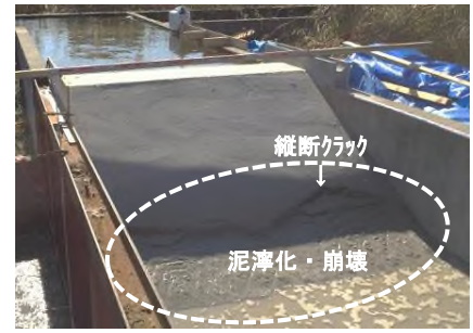
写真-2 側方移動状況(④73分後)
