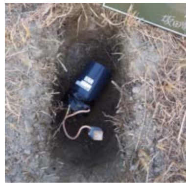
写真-2 侵食センサの設置状況
