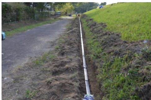
写真-1 のり尻における光ファイバセンサの設置状況
