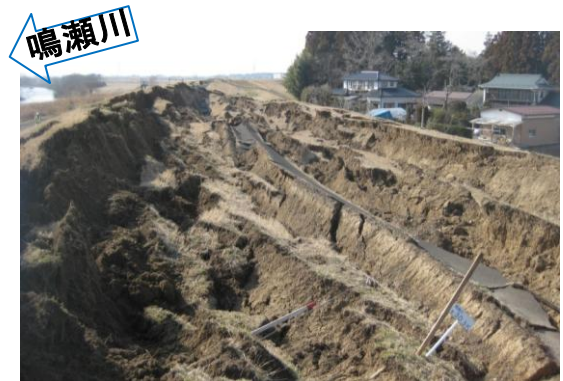
図-2 閉封飽和域の液状化による河川堤防の被災事例(鳴瀬川下中ノ目地区)
