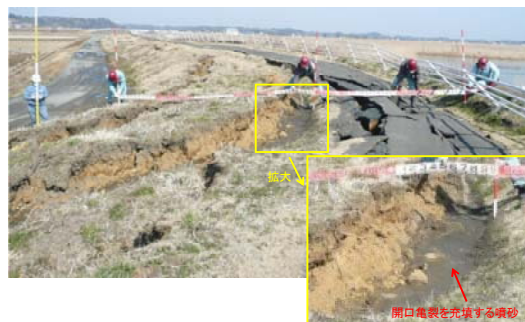
(a) 左岸 8.0k 天端付近
