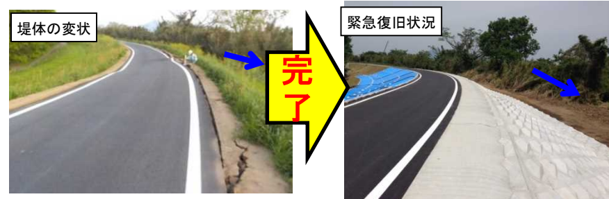
■緊急災⑩ 4/30完了 緑川右岸 9 k 2 0 0 付近 (熊本市)
