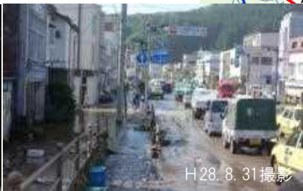
久慈市内 被害状況
