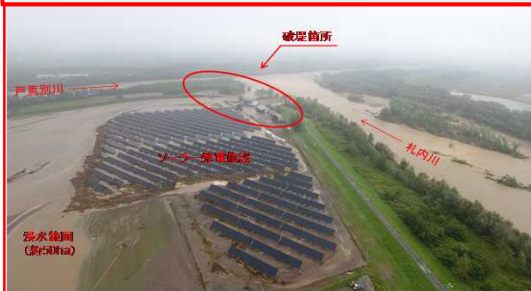
札内川の堤防決壊状況(帯広市)
