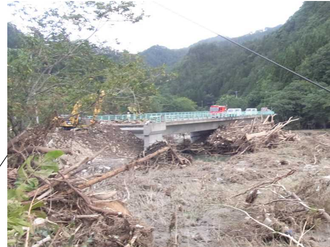
橋梁被害状況(乙茂地区)
