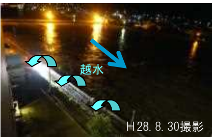
久慈川(右岸)越水状況
