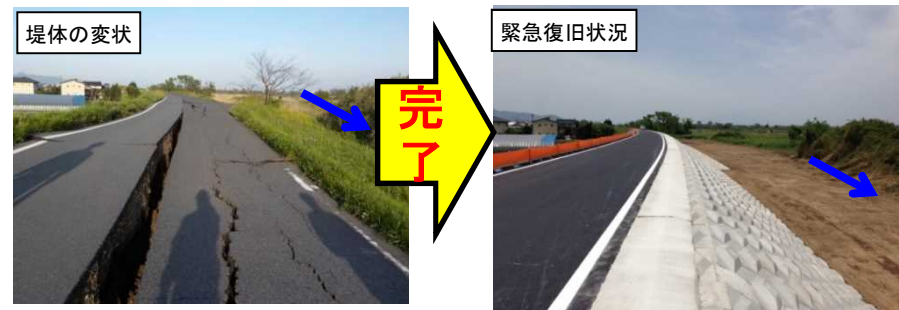
■緊急災⑨ 4/30完了 緑川左岸 1 2 k 4 0 0 付近 (熊本市)
