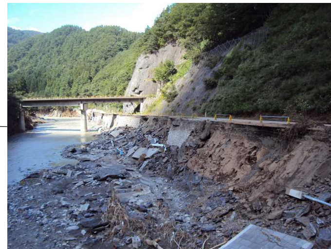
国道455号の道路被害状況(二升石地区)
