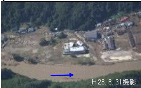
小本川 被害状況①
