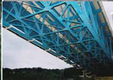
平戸橋 旧トラス桁の両側にトラス桁を拡幅
