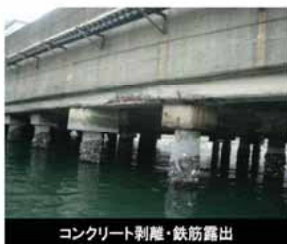
コンクリート剥離・鉄筋露出(左図の拡大)
