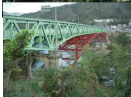
三好橋 吊橋を上路式アーチに改造
