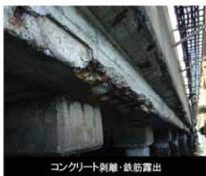
コンクリート剥離・鉄筋露出(左図の拡大)
