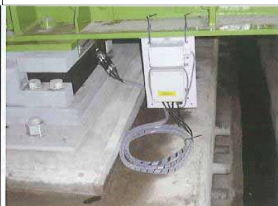
図-10 ゴム支承反力のリアルタイムモニタリング(支承別)
