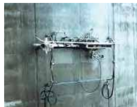
サイロ壁面の清掃ロボット 14
