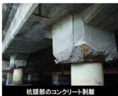
コンクリート剥離・鉄筋露出
