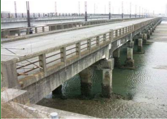
橋梁名：厚東橋 (国土交通省中国地方整備局 国道190号) 建設年：昭和10年に竣工(76年経過)
