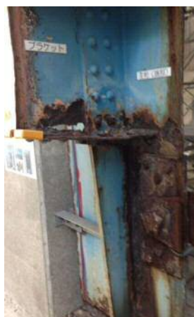
国道一号線矢作橋
