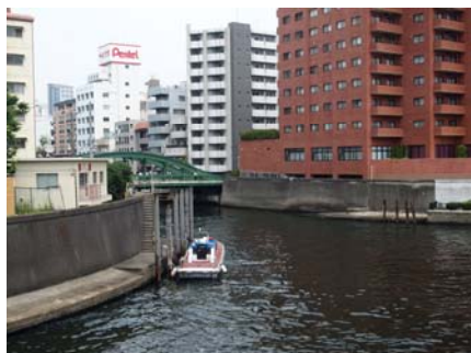
水辺を遠ざけている直立護岸
