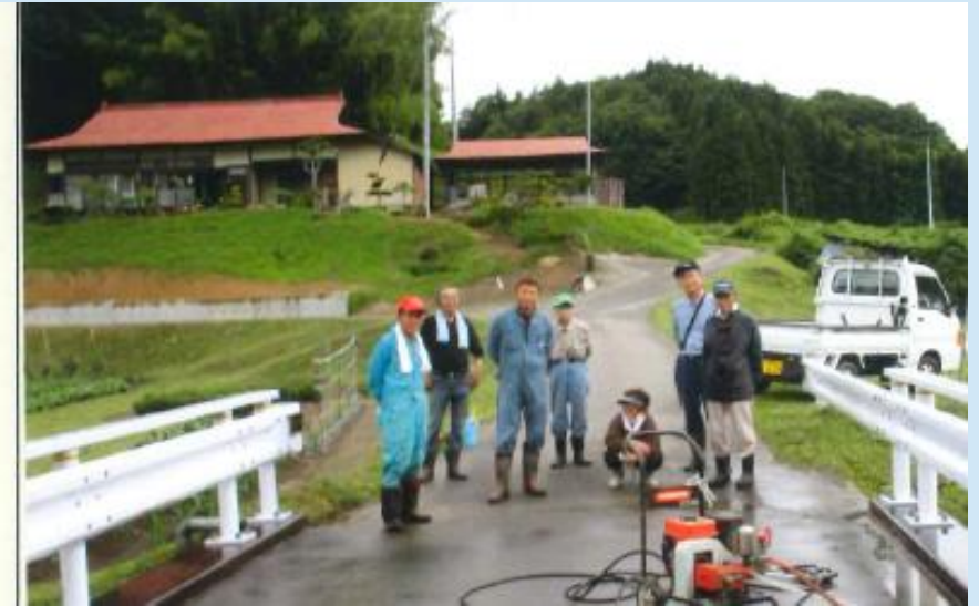
その他損傷や点検・清掃の様子
