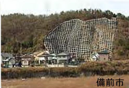
法枠・法面工（崖崩れ・地すべり）
