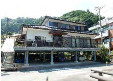
2022年球磨川水害で浸水被害を逃れた混構造(S+木)住宅(球磨村・一勝地)
