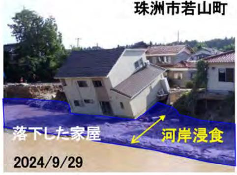
**奥能登豪雨による複合災害:** 地震による地盤隆起による河川勾配の変化、急峻な地形や堤防の弱体化、短時間に豪雨が集中により多数の土砂災害や河川氾濫など 25
