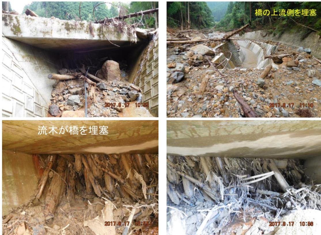
図 3.8.13 流木により閉塞した山地小河川の橋梁
