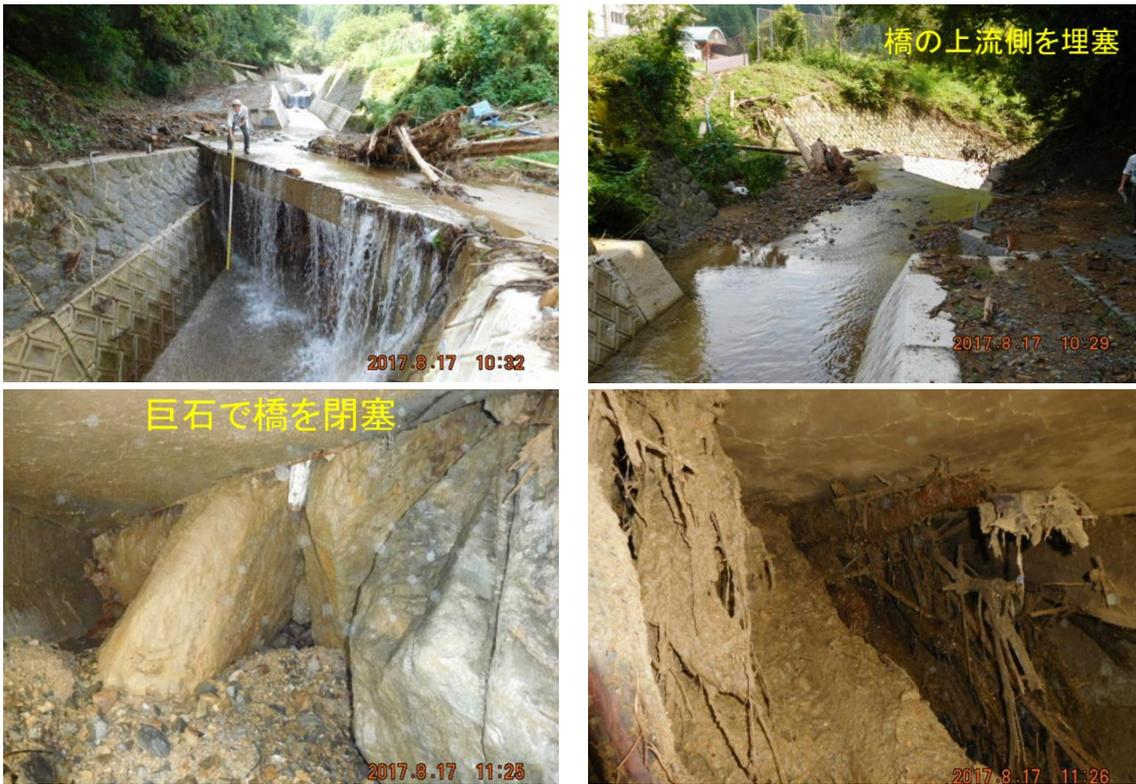
図 3.8.14 巨石により閉塞した山地小河川の橋梁
