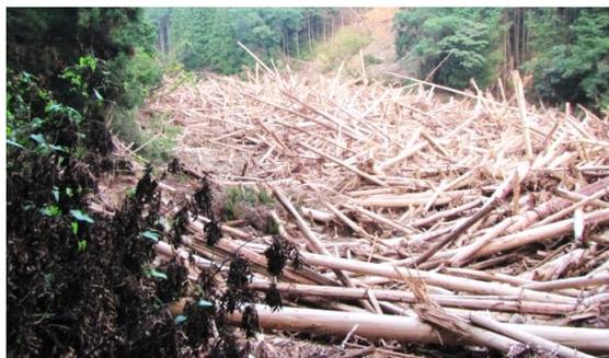
**図4.3.3** 須川第1砂防堰堤における流木捕捉の様子
