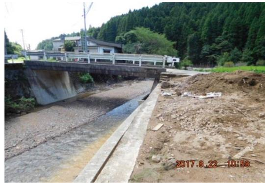
図 3.8.19 大肥川に架かるひさげ橋（上流側で溢れている）
