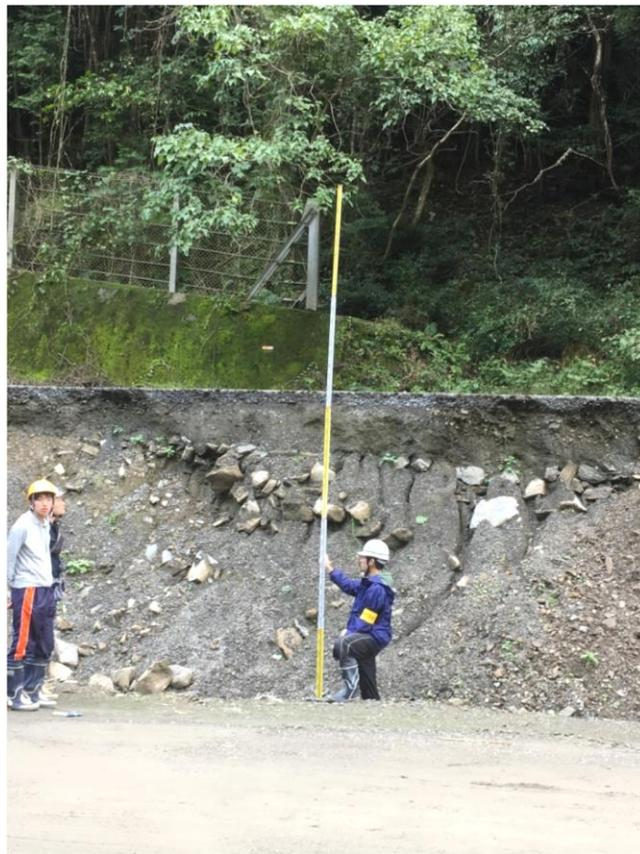
図 3.1.5 道路面の崩落高さ
