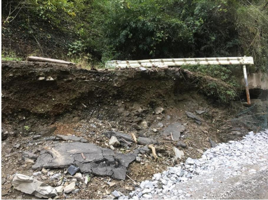
図 3.1.10 B 地点の道路基盤崩落
