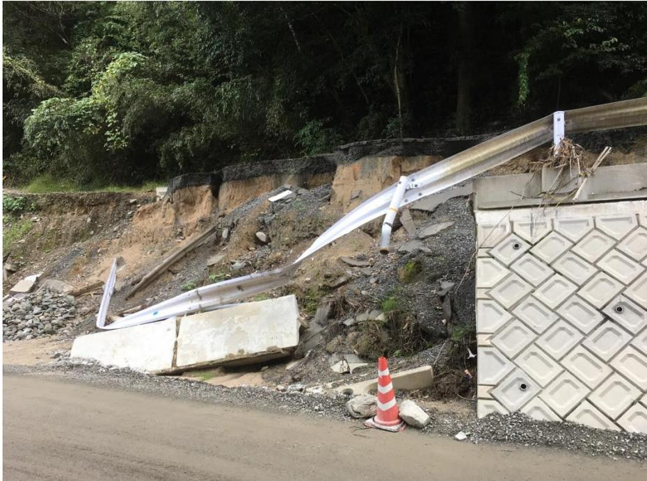
図 3.1.11 B 地点の道路基盤崩落
