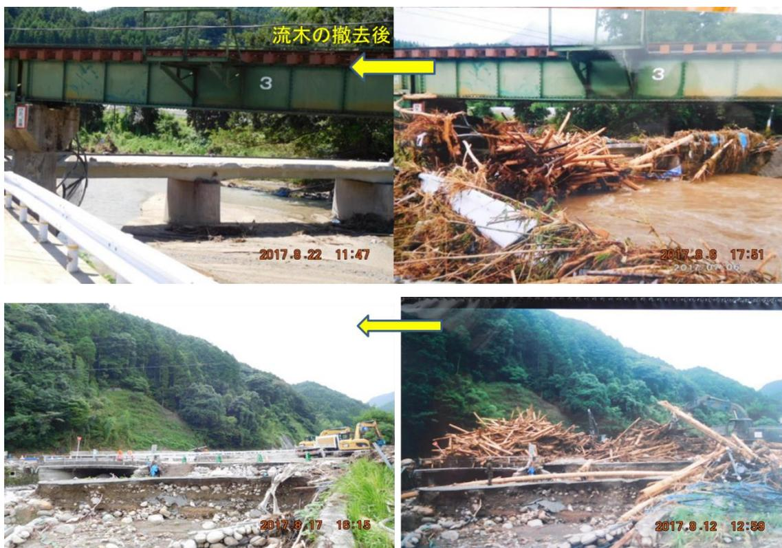
図 3.8.17 橋梁部での流木の集積による河道の閉塞（大肥川・宝珠山川）
