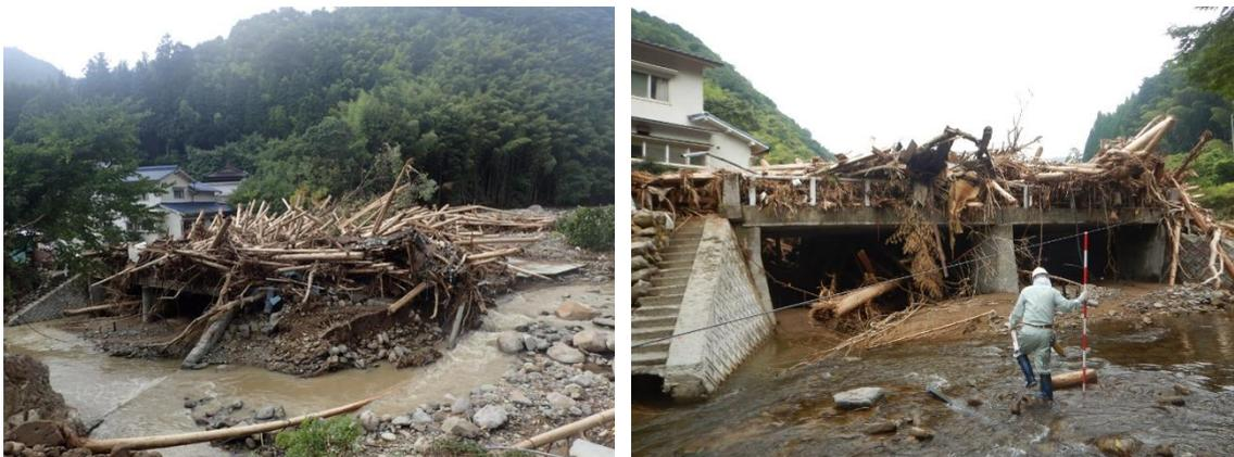
図 3.8.15 橋梁に集積する流木（鶴河内川）
