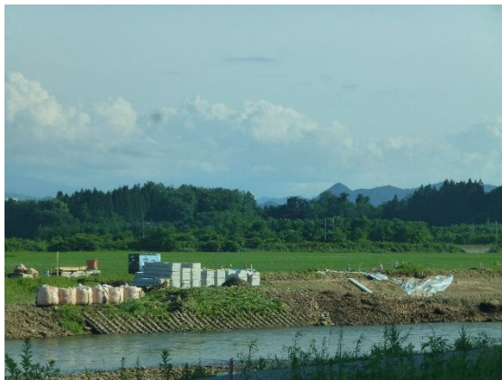
写真—1-1 堤防の被害
