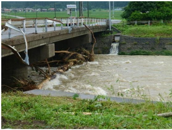
写真-2-7 橋脚に堰止められた流木
