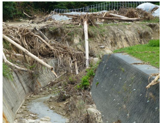
写真-3-8 河川への流木の流出
