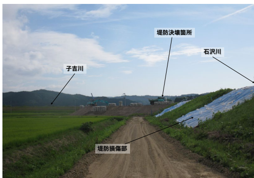
写真8 2011年時の堤防決壊状況(1)
