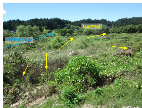
写真4 最上流部堤防決壊位置の河道植生状況
