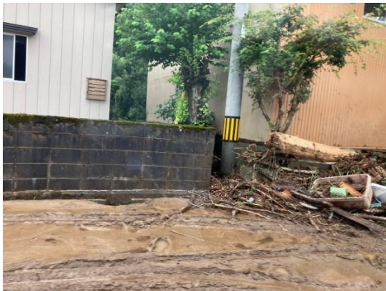
写真-2-8 住宅への被害
