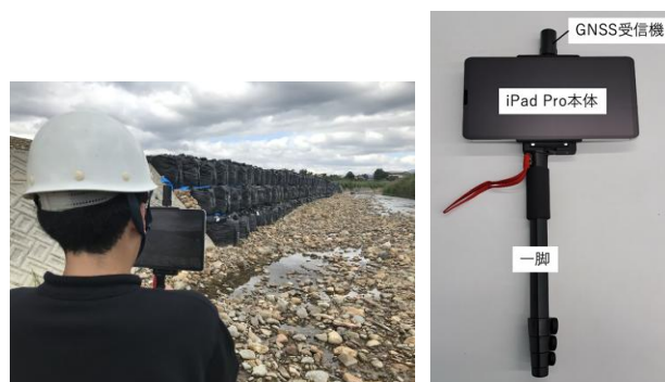
図 2 測量実施風景および測量機器外観
