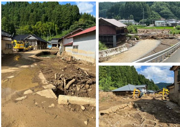
写真2 荒瀬川中上流域の沢から流出した土砂流木。
