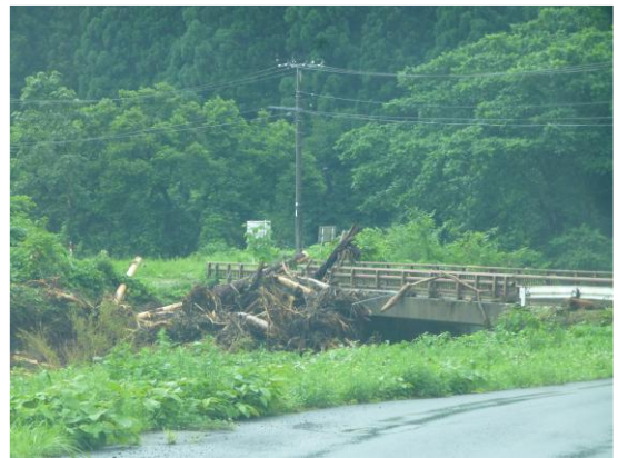
写真-3-3 橋に引っ掛かった流木
