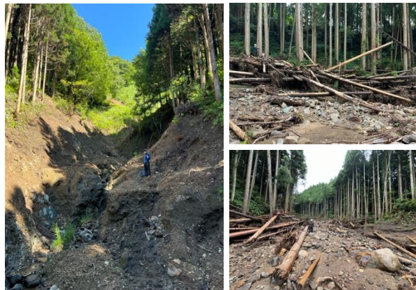
写真1 左: St. 3の土石流発生源(深層崩壊), 右上および右下: St. 3の下流側に位置する流木天然ダム。
