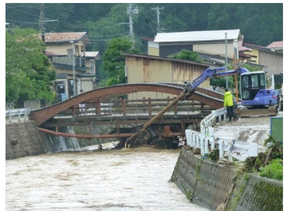
写真-2-9 橋に引っ掛かった流木
