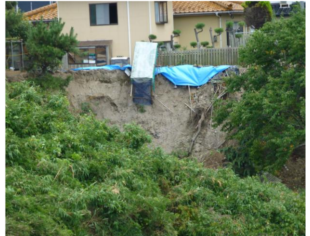
写真-3-7 洗堀を受けた河川
