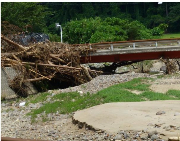
写真-3-10 橋梁への流木の流出
