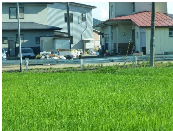
写真—1-2 民家のへの被害
