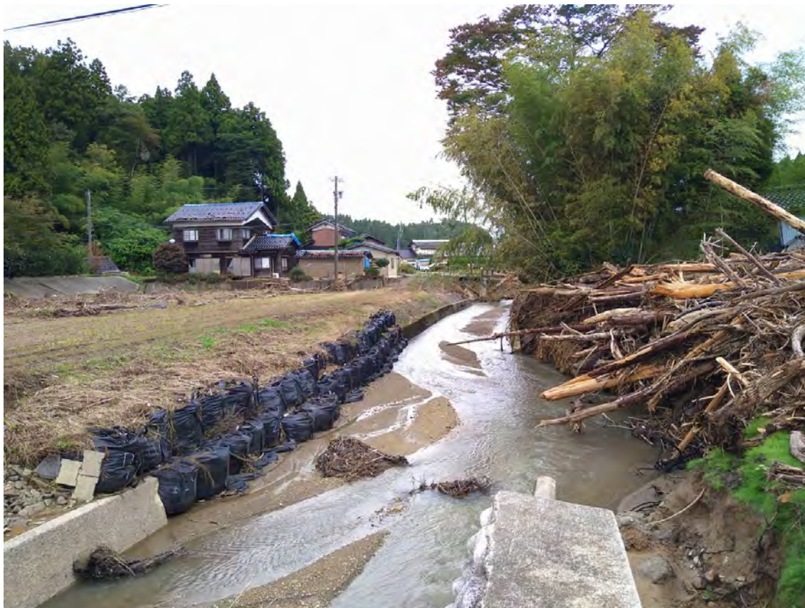
図 10-18 竹中川で見られた流木の堆積状況(10 月 29 日撮影)
