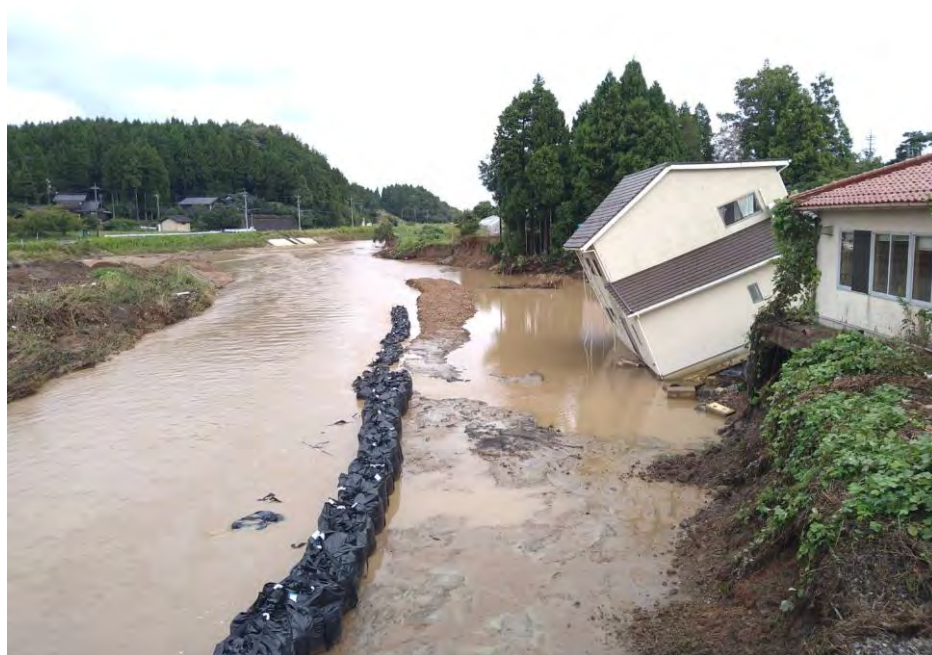
図 10-5 測定地点 1 の近傍での河岸侵食による家屋の崩落状況 (2024 年 10 月 9 日筆者らが撮影)
