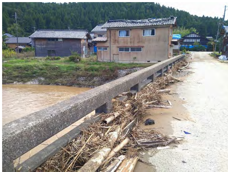
図 10-8 測定地点近傍の橋脚に残る痕跡（左岸側より撮影）
