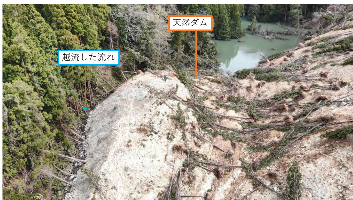
図 1-3 天然ダム天端付近の様子
