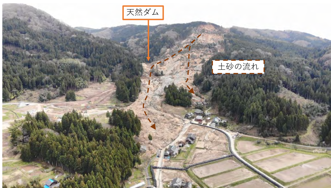
図 1-2 崩壊が発生した斜面と泥流が流下した領域
