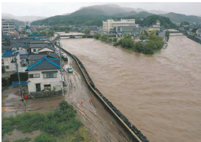
写真 14-1 河川が氾濫した輪島市内の様子 3)
