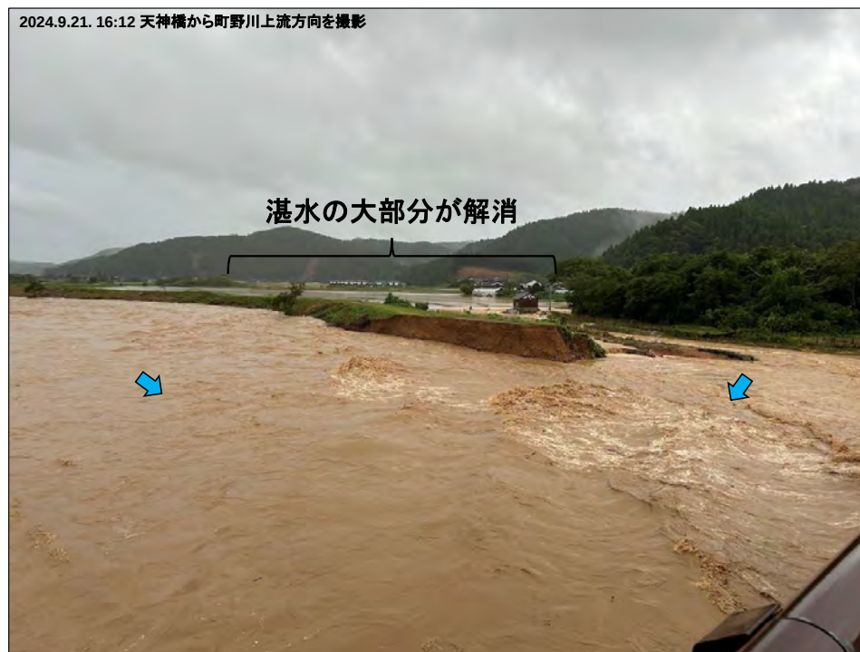
図 12-11 逆破堤から約 1 時間後の左岸堤内地（付近住民からの提供画像に佐藤加筆）
