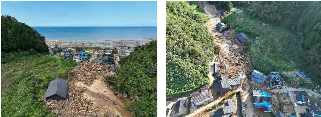
図 3-7 尊利地川における土砂と流木による家屋の被害 (2024 年 9 月, 流木撤去前)
