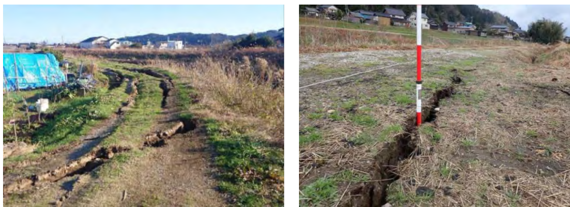
図 3-3 液状化による河川被災の事例（左：上庄川大野外，右：上庄川七部一外，写真提供：いずれも富山県）
