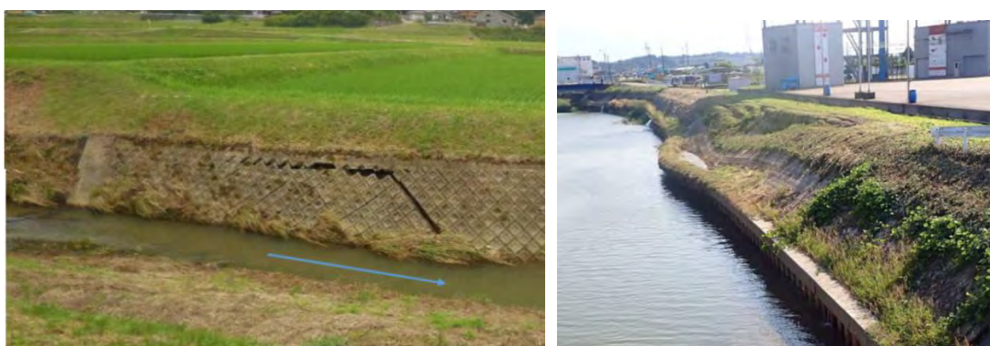
図 3-2 地震動による被災の事例（左：小矢部川水系五郎丸川，右：下条川，写真提供：いずれも富山県）
