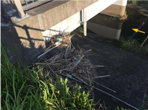
写真 2.6 橋桁への漂流物の集積状況（宮之城川・城ノ下橋）；写真 E
