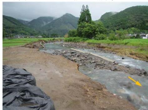
写真 2.12 河岸（右岸）流失箇所；写真 D
