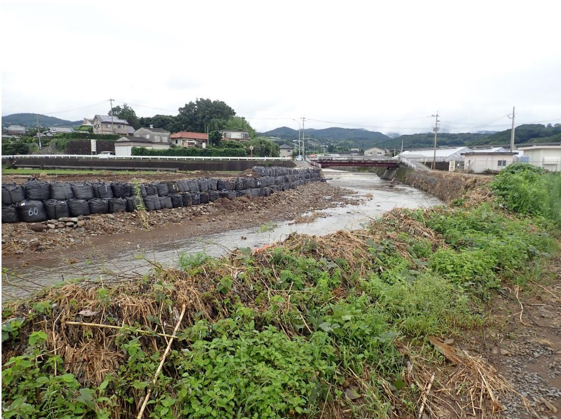
写真 7.1 佐那河内川破堤部の様子。写真は下流側より撮影。右岸側が土嚢にて応急復旧されている
