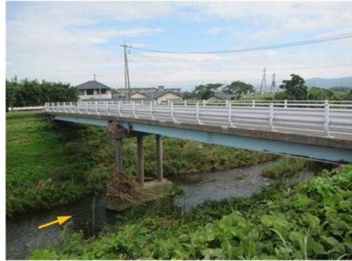
写真 2.5 橋梁への漂流物の集積状況（宮之城川・麓橋）；写真 D
