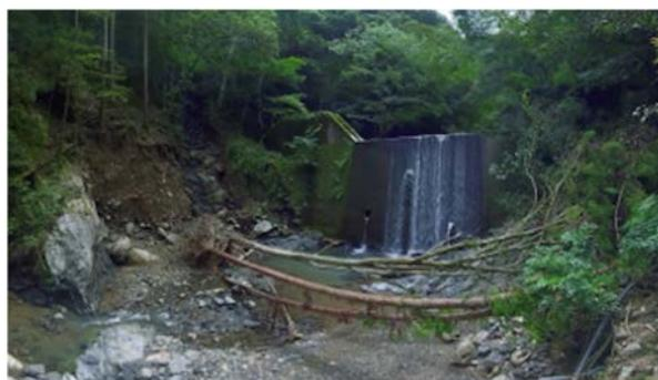
写真 12.8 P6 の上流に砂防ダムが設置されていたが、左の側岸から土砂が抜けていた。
