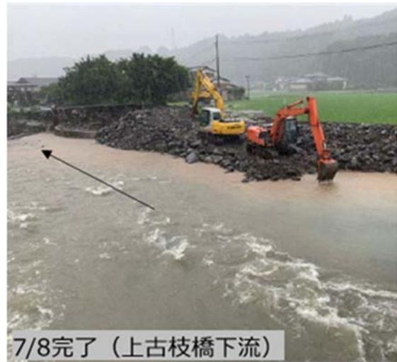
写真 6.3 令和2年7月6日浜川 4km 上古枝応急復旧工事の様子
