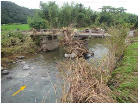
写真 2.17 橋梁への漂流物の集積状況；写真 I
