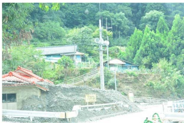
写真 12.9 P7 における土砂災害の被災状況支流から流出した礫が本川まで到達していた。
