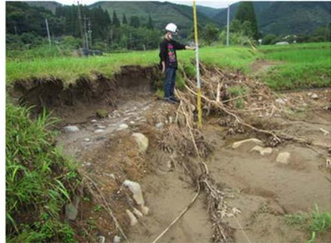
写真 2.16 川裏部（左岸）被災状況；写真 H
