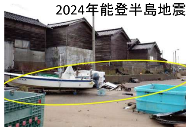
2024年能登半島地震 高潮対策で嵩上げで津波被害を逃れた集落(志賀町赤崎漁港)
