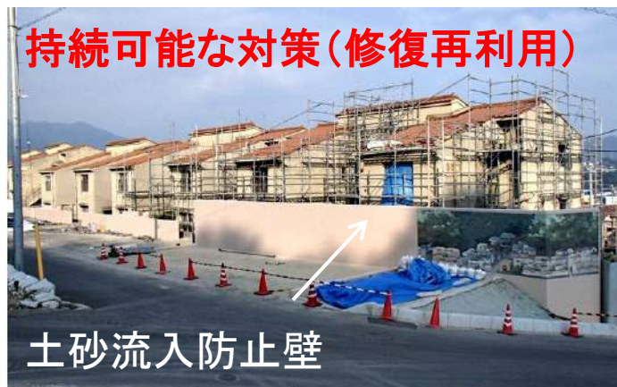
県営緑丘団地5号館（RC造）の被害（左：西側住戸、右：修復中：福正建設HP）
