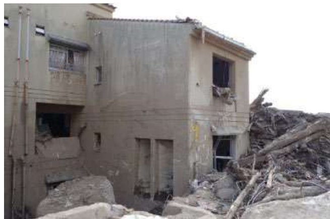
県営緑丘団地5号館（RC造）の被害（左：西側住戸、右：修復中：福正建設HP）
