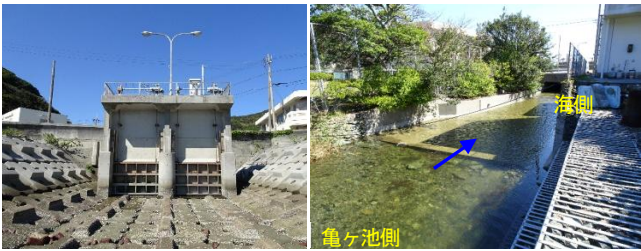
図-2 水門の下流面(左)と接続水路(右)の様子
