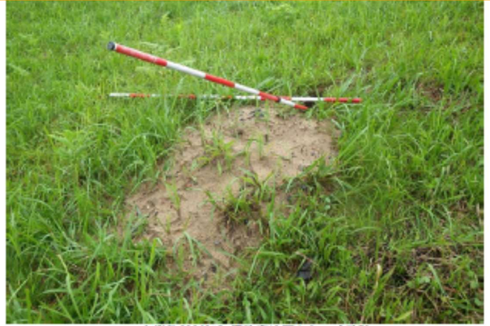
左岸2k600付近 堤防裏法面からの噴砂跡
