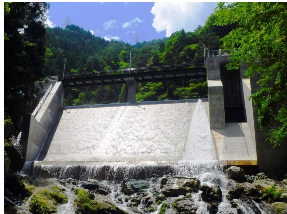
四国電力明谷ダム (ゲートレス化工事後)
