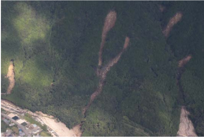
複合的に発生した表層崩壊・土石流
