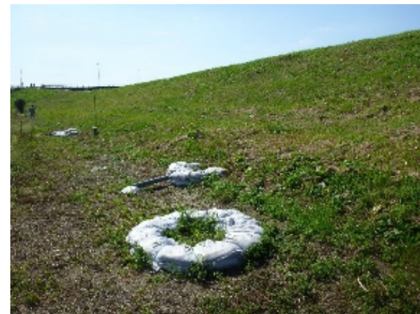
鬼怒川左岸20.5k付近 (平成27年9月洪水)
