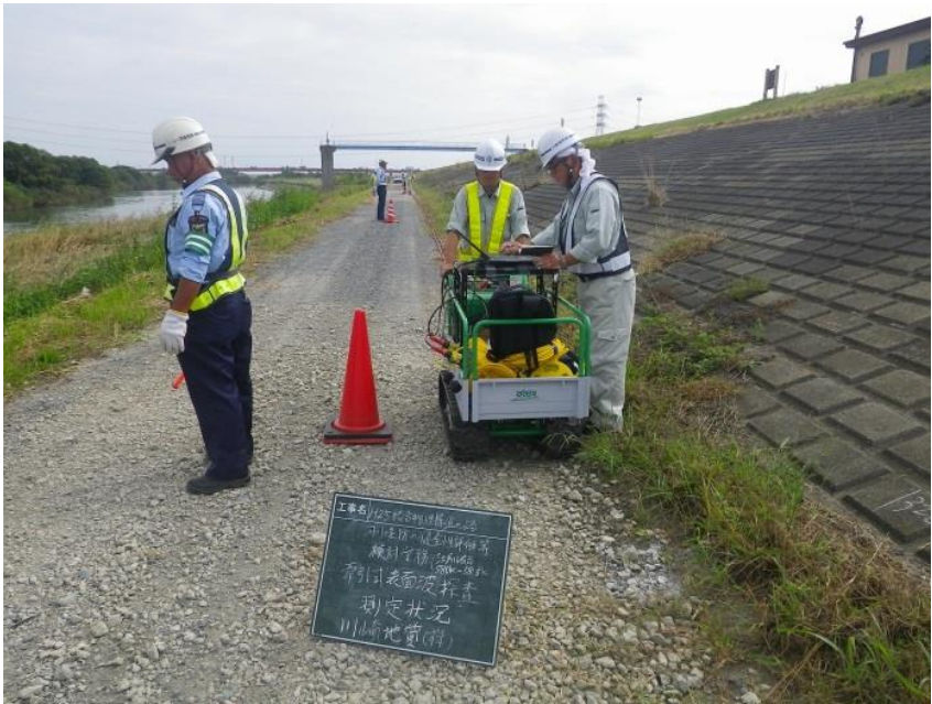
牽引式表面波探査測定状況
