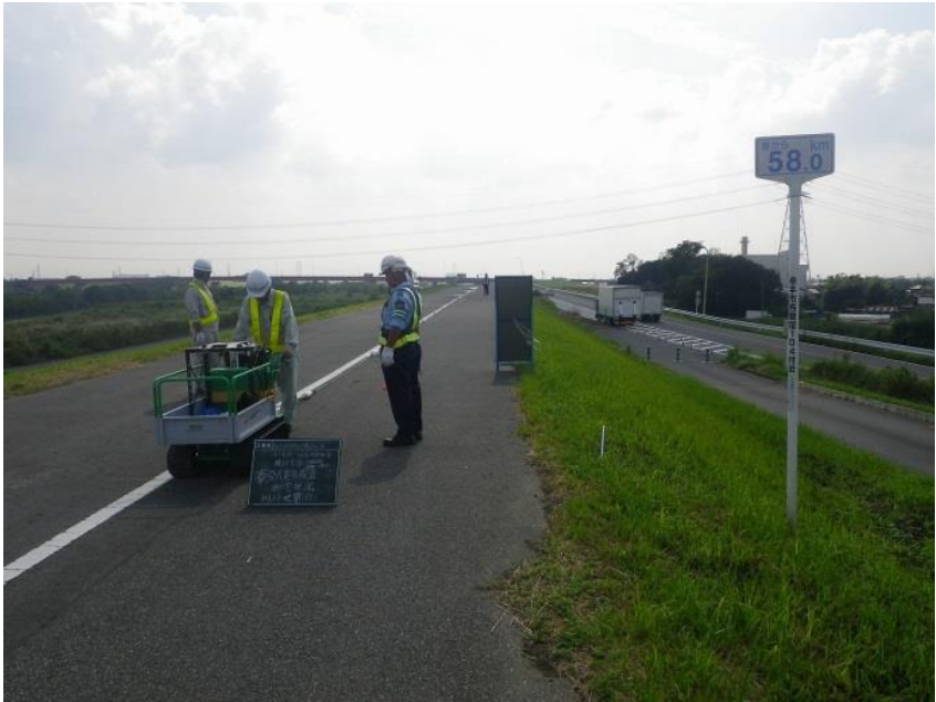
牽引式電気探査測定状況
