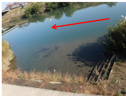
上流側に土砂堆積
