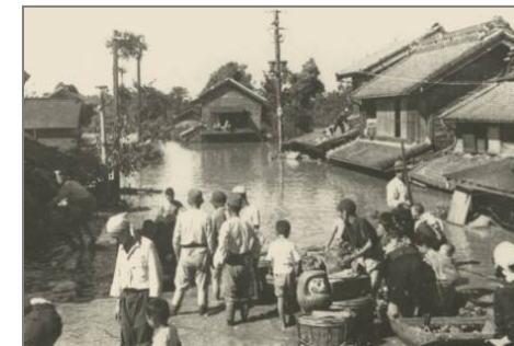
埼玉県栗橋町付近浸水状況 (S22)
