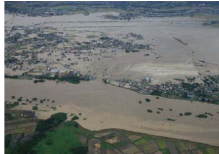
常総市三坂町決壊状況 (H27)
