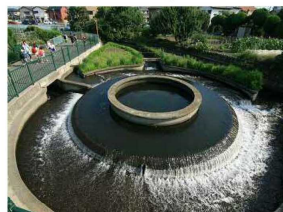
昭和37年に設置された円筒分水堰
