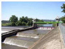
水源である烏川左岸に設置された頭首工
