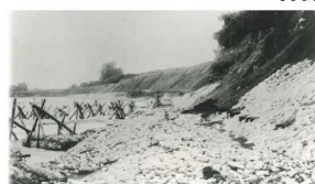
古くから天狗岩取水口付近で使われていた水制工法「越中砕」
