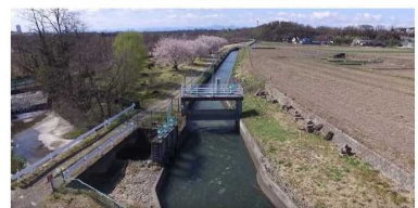
1998年のかんがい排水事業により改修された「制水門」と「余水吐門」
