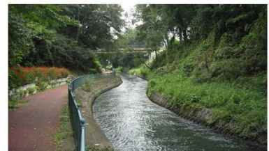
秋元長朝により開削された「天狗岩用水」
