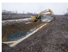
河道掘削 (石狩川水系、北海道開発局)
