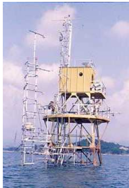
写真-2 旧観測塔（白浜海洋観測塔）
