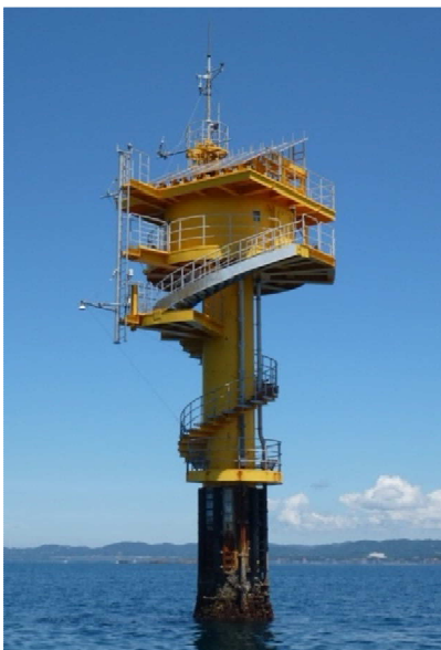
写真-1 田辺中島高潮観測塔
