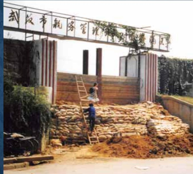
武漢市中心部の道路沿いに設置されている防洪壁と緊急時の締切方法('98.9.22)
