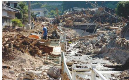
→上流部で発生した土砂が河道に流入し、河川の下流部で土砂と洪水が氾濫する現象
