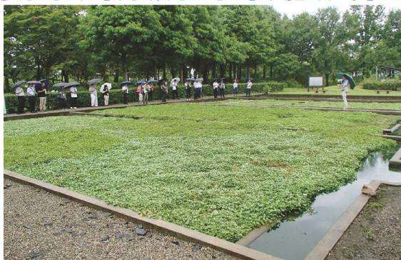
最初の見学先は、赤野井湾流域流出水対策施設です。琵琶湖へ流入する汚濁負荷軽減のための河川浄化を行っており、守山川からの流入負荷を水生植物により浄化する施設などを見学しました。
