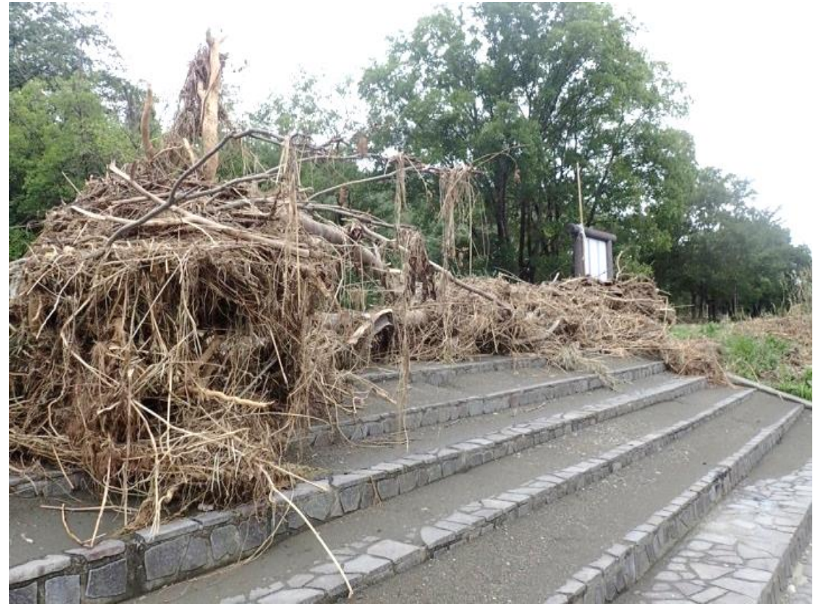
施設内、いたるところがこのような状態となっていた
