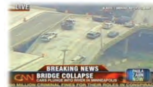
米国・ミネアポリス崩落事故 (2007年)
