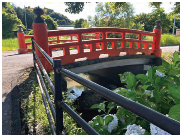
草履拔橋（R C T桁 L=5.50m W=6.00m 1934（S9）年）
