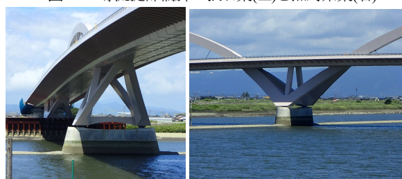
写真-9,10 導流堤部橋脚完成写真
