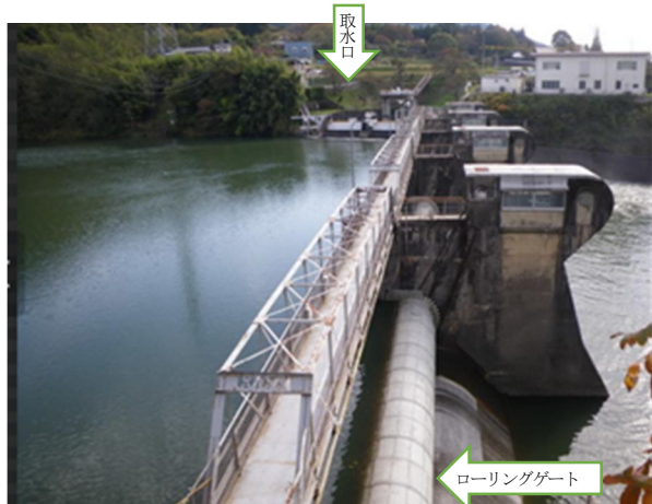
図7 南向ダム（ピア、ローリングゲート、取水口他）
