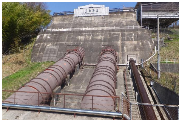
図4 水圧鉄管（現在は2条、当初は3条）
