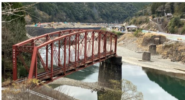
図-1 被災前後の球磨川第一桥梁
