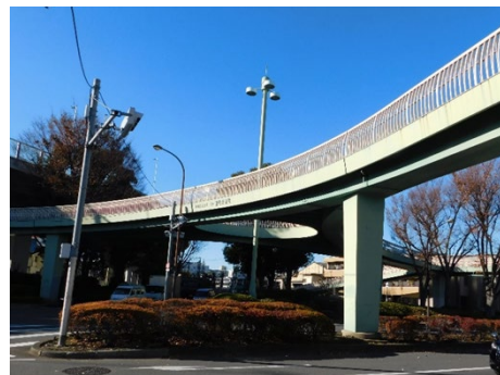
図-15 蓮根歩道橋（2022年小澤撮影）
