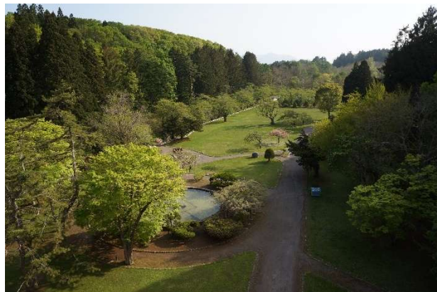
写真12 堤頂より下流側の広場と遠方の函館山を望む。ここは赤川水源池公園と呼ばれ、桜と紅葉の名所として市民に親しまれている
