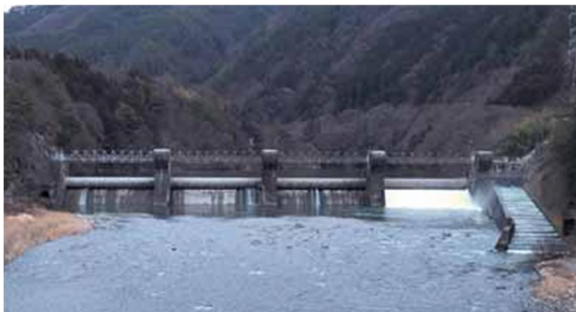
図6 南向ダム（吉瀬ダム）全景（下流より）
