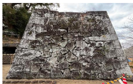
写真-4 玖島城大手門口石垣
