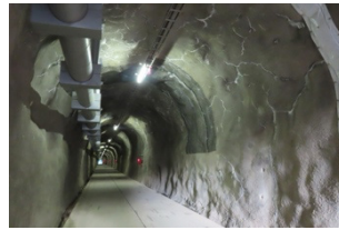
図-22 改修された坑内 (道瀬隧道)
