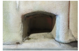
図-23 埋没したニッチの痕跡 (海野隧道)
