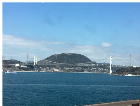
図-7 関門橋（2023年橋本撮影）
