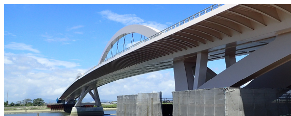
写真-8 すっきり見える上部工の外景観(筑後川橋)
