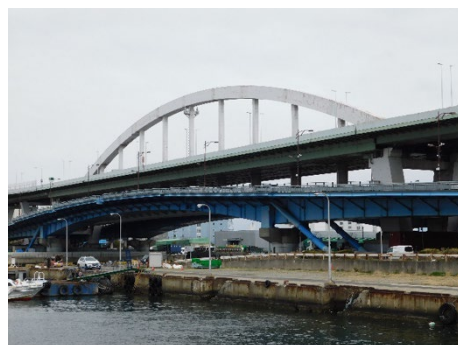
図-13 南港水路橋（2024年小澤撮影）
