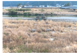
図-13 旧・銚子橋の基礎 (銚子川)
