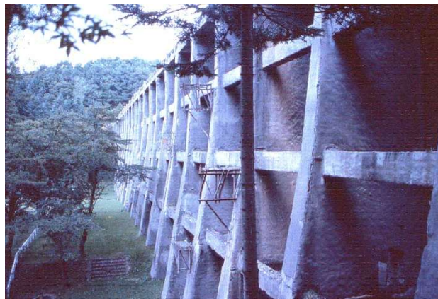
写真8 1976（昭和51年）堤体のモルタル吹付け（写真：加藤静雄）
