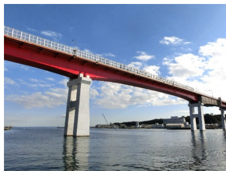
図-6 城ヶ島大橋（紅林撮影）
