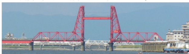
写真7 筑後川昇開橋
