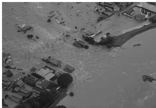
写真 越流状況
