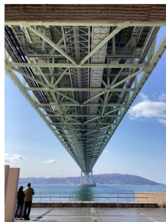
図-8 明石海峡大橋（2023年橋本撮影）
