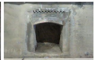
図-12 ニッチ(格納庫)の痕跡 (道瀬隧道)
