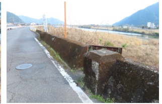
図-14 旧・銚子橋の親柱 (銚子川左岸)
