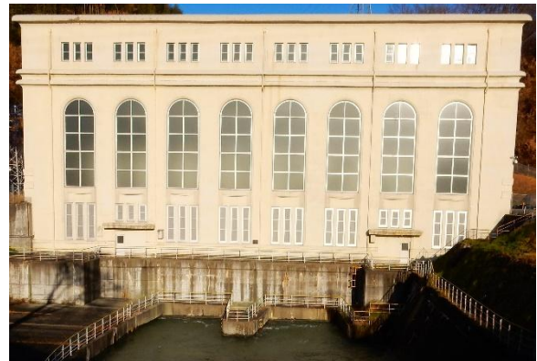
図 1 南向発電所本館全景（建物下部から放流）
