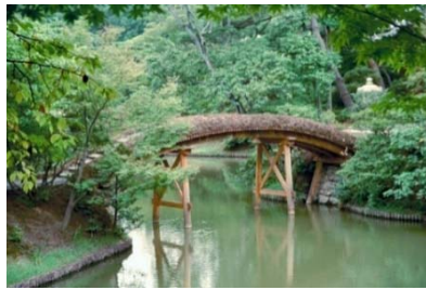
写真-16 桂離宮の土橋
