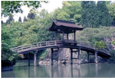
写真-6 永保寺の無際橋
