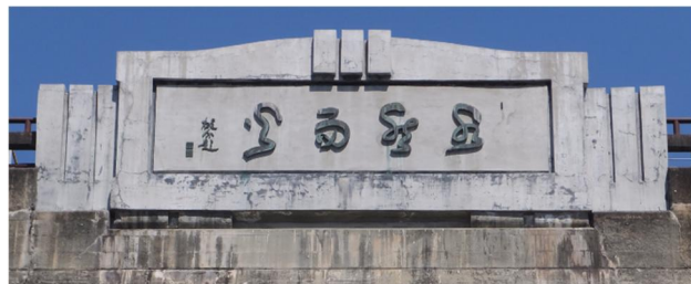
図12 水槽の壁に掲げられた「水然而火」の碑
