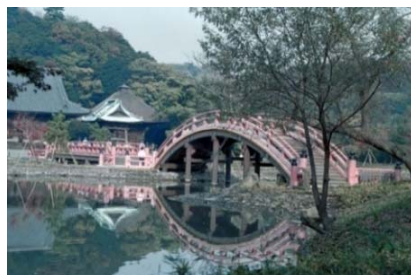
写真-5 称名寺庭園の反橋と平橋
