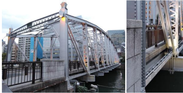
図-10 南高橋（旧両国橋）（建設時用途：路面電車及び馬車）
