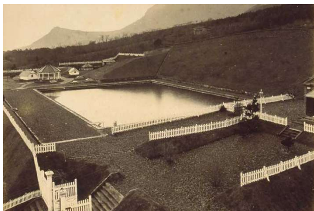
写真2 函館創設水道の元町に建設された低区配水池及び三号結合井．現在は覆蓋され公園になっている（土木学会土木図書館蔵）
