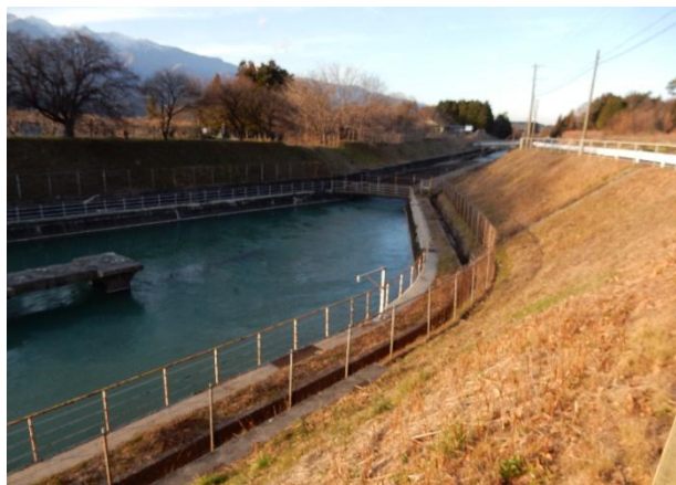
図5 導水路（奥）と水圧鉄管へ流下させる水槽
