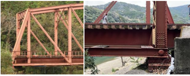
図-9 端柱及び端部下弦材
