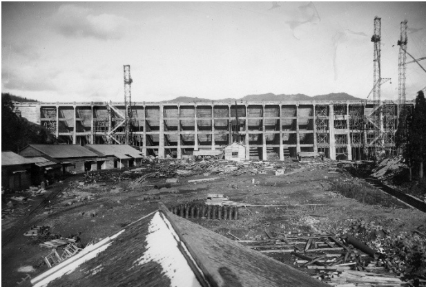
写真3 概成したダム下流側全景。大変スレンダーな部材構成である。厚くなっている扶壁2基はジョイント部（函館市中央図書館蔵）
