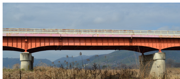
図-1 ゲルバー桁橋（京都市御幸橋）
