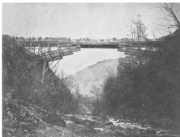
図-3 直利橋（木造、刎橋）
