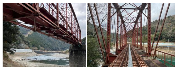
図8 (左)下弦材及び横構、(右)斜材及び垂直材
