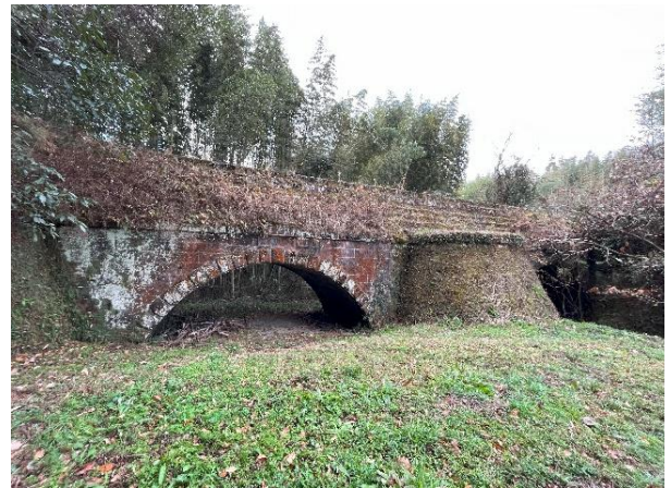
図-1 横瀬二連水路橋
