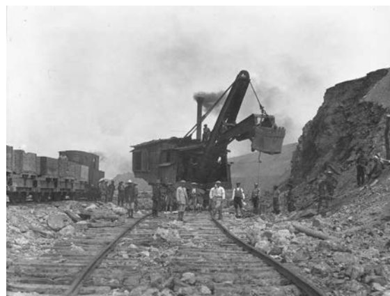
写真-2 多くの地域住民が従事した大河津分水工事
