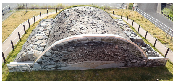
写真-11 導流堤の陸上復元(筑後川昇開橋展望公園)
