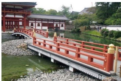
写真-3 平等院鳳凰堂北側の橋
