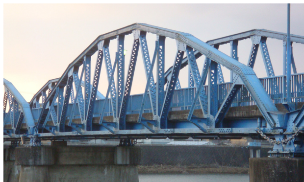
図-12 ボウストリングトラス（京都府綾部大橋）
