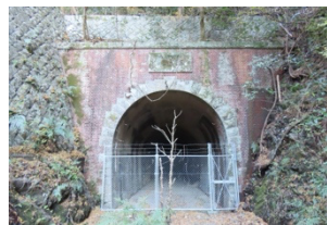
図-9 バット(ハーフ)ゲート (三浦隧道松阪方)
