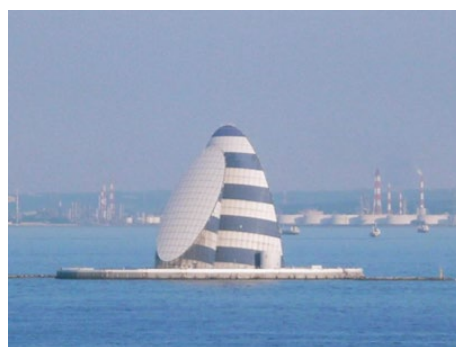
図-10 東京湾横断道路「風の塔」 注4)
