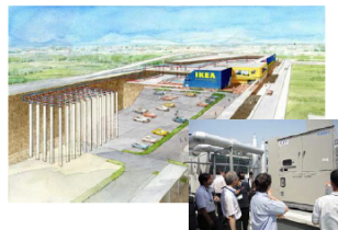
IKEA福岡新宮 ストア 延床面積：31,661 m 2 (2フロア構成) 完成・開業日：2012年4月 地中熱源能力：約500 kW、150RT *再生可能エネルギーの使用割合はおおよそ30% 熱源杭の本数：100mの長さの杭70本 (IKEA JAPAN NEWS 2011.4.19)
