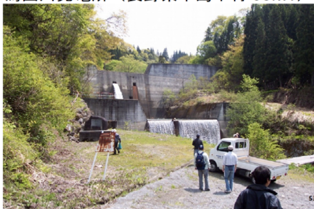
馬曲川発電所（長野県本島平村 95kW）
