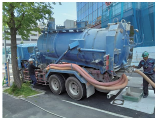
従来の流動化処理土施工と同じ運搬車を使用
