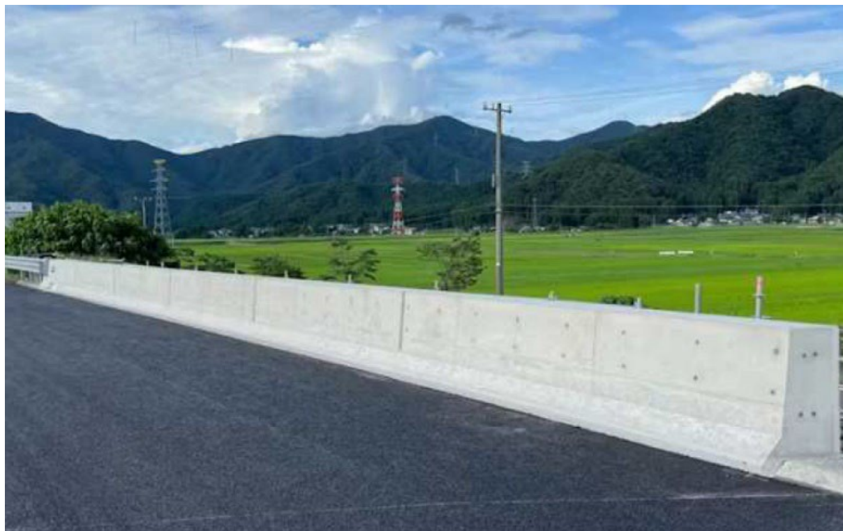
環境配慮型コンクリートによる橋梁壁高欄の施工事例
