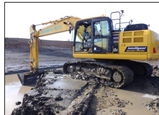
⑧ICTによる現地施工
