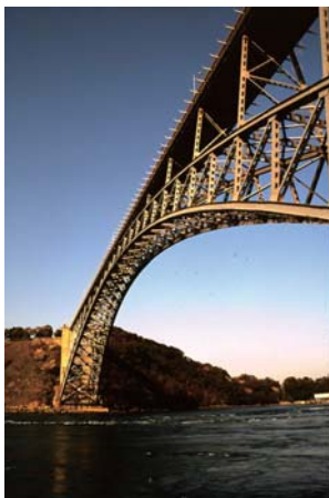
写真2 西海橋 長崎県伊ノ浦瀬戸にかかる支間216mの固定構造アーチ橋であり、当時としては世界で初めて施工時にプレストレスを添加し、上限支承の引張応力を除去するとともに、アーチの応力分布の改良を試みた(写真西海市観光協会提供)。
