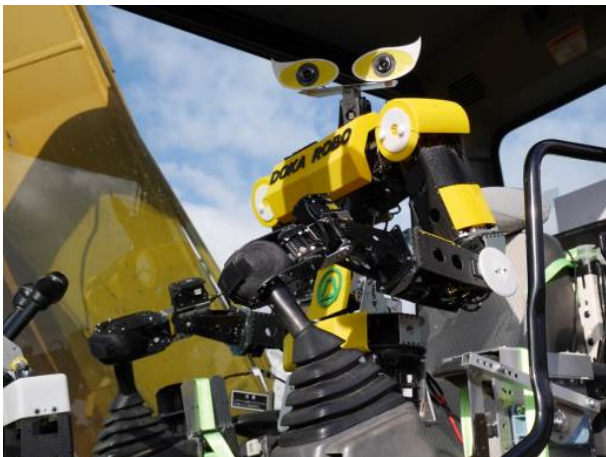
写真-1 無人化施工ロボット 雲仙普賢岳
