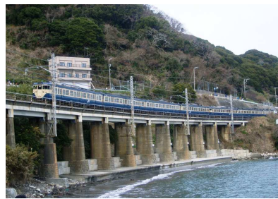
写真-1 古い構造物の例：経年 95 年 (1920 年) の RC 橋 (内房線山生橋梁)
