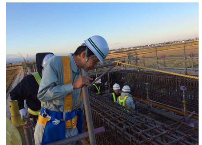
写真-4 津波被害を受けた鉄道の復旧工事に携わる石橋氏
