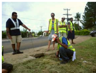
写真-3 漏水探査技術指導の様子 (右下男性が音聴棒を使用)
