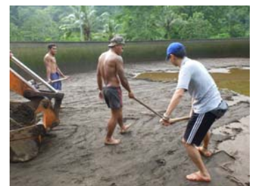
写真-2 浄水場の砂濾過池の砂掻き取り作業 (右が梶原氏)
