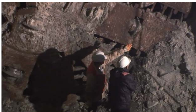
写真2 シールドマシンの解体現場を確認する今石氏(左側)
