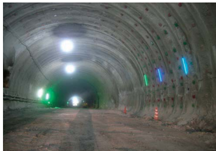
写真2 トンネルでの設置風景
