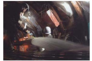
写真-2 湧水帯では最大毎分 15 トン以上の水と格闘 (写真：NEXCO 中日本)
