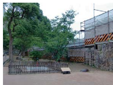
写真-5 見学コース協の工事
