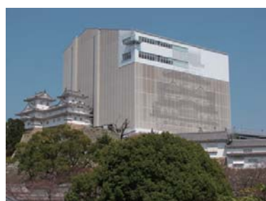
写真-1 姫路城の素屋根 （天空の白鷺 HPより）
