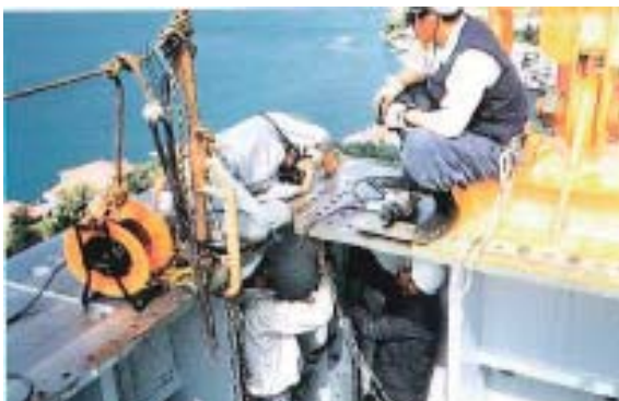
写真-2 主塔パネル間のボルト締め
