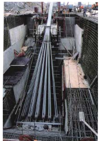
写真-1 放射状アンカースパン部 (以下写真はIHIより提供)
