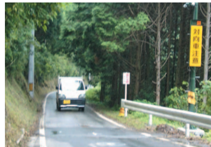
写真-2 すれちがいできない山道で対向車の存在を光って知らせる中山間道路走行支援システム
