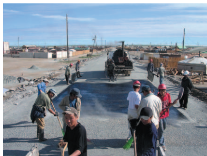
写真-2 舗装工事に参加する住民たち
