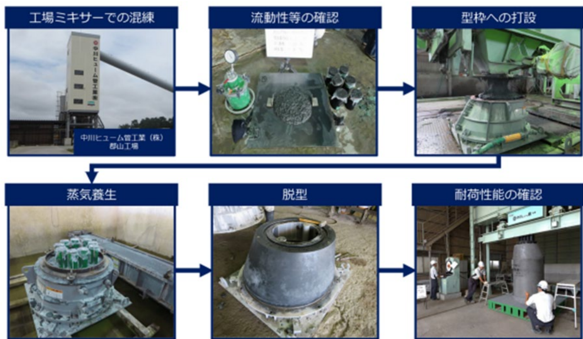
図 3.3.1-6 工場における EeTAFCON 製プレキャスト製品の製造風景 6) (出典：電力中央研究所，2021)
