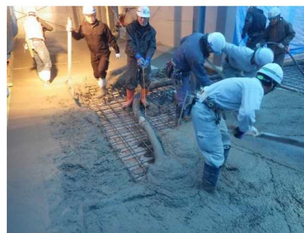
低炭素型のコンクリートの施工状況
