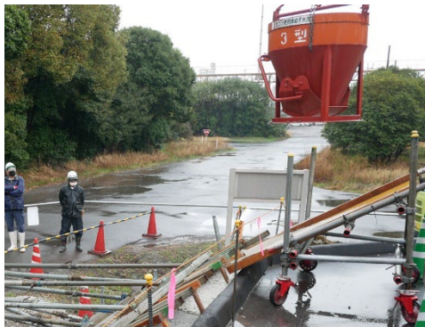
写真 20.3 のり面保護コンクリート
