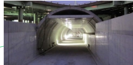
中央環状品川線大井地区トンネル
