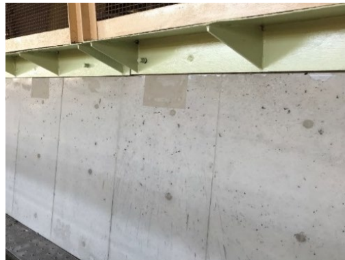
製鉄所内RC擁壁断面補修適用事例
