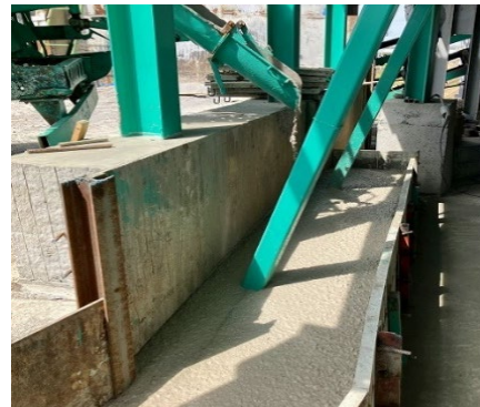
写真 20.4 建屋基礎補強（増し打ち）
