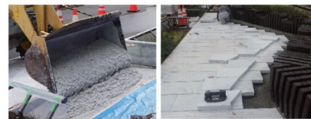
現場打ち舗装施工状況
