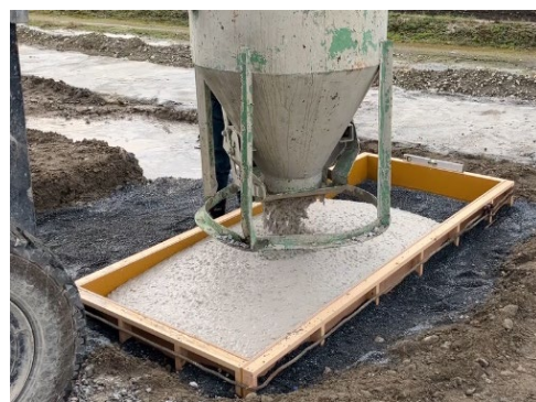
写真 20.2 土間での流動充填性
