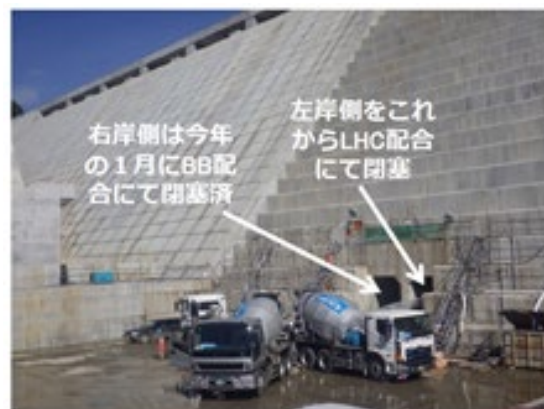
厚幌ダム閉塞工事での打設状況
