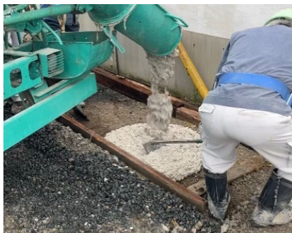
写真 20.5 土間コンクリート
