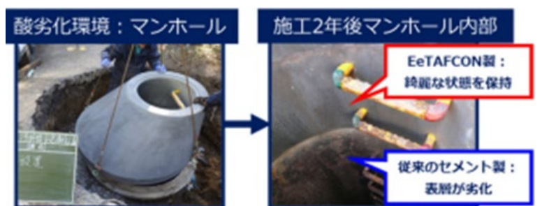
図 3.3.1-7 EeTAFCON 製プレキャスト製品（マンホール） 6) (出典：電力中央研究所，2021)
