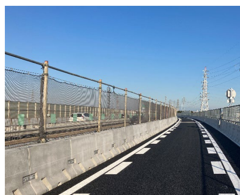
東名阪 弥富高架橋 PCa 仮設防護柵
