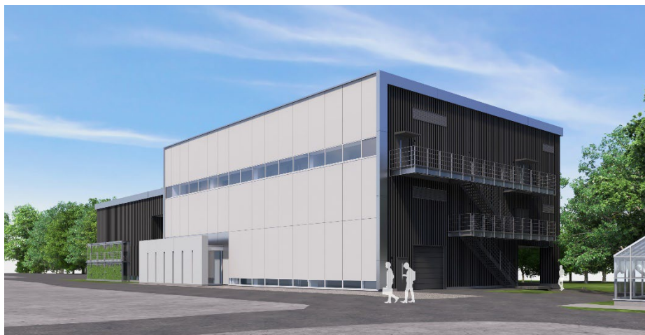
クリーンクリート N を用いた PCa 外壁部材適用予定 当社実験施設
