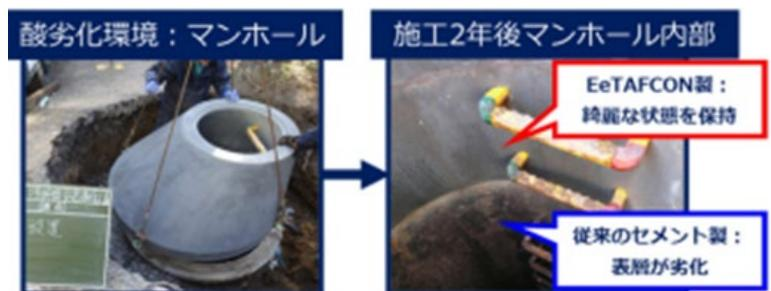
図 3.3.1-7 EeTAFCON 製プレキャスト製品（マンホール）<sup>6)</sup>
