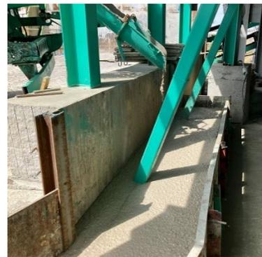
写真 20.4 建屋基礎補強（増し打ち）
