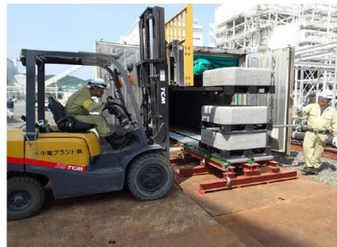
図 1.2 養生槽へのコンクリート搬入状況
