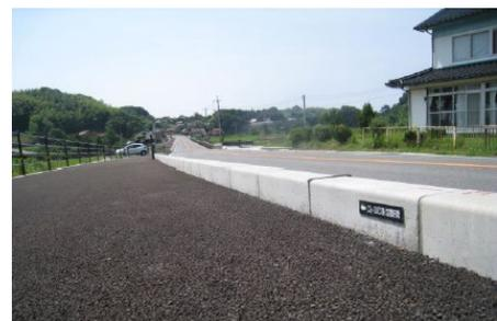
図 1.4 CO<sub>2</sub>-SUICOM 製歩車道境界ブロック
