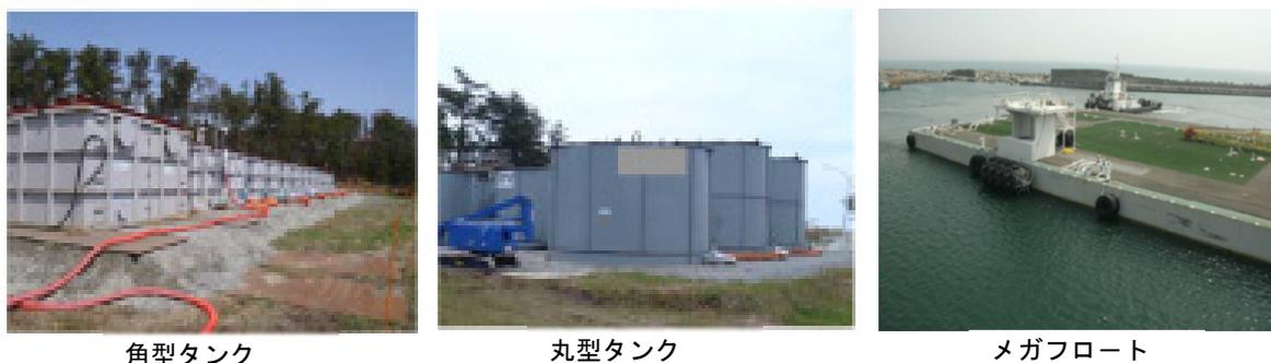
図 2-18 低レベル用タンク及びメガフロートの設置 <sup>13)</sup>より引用
