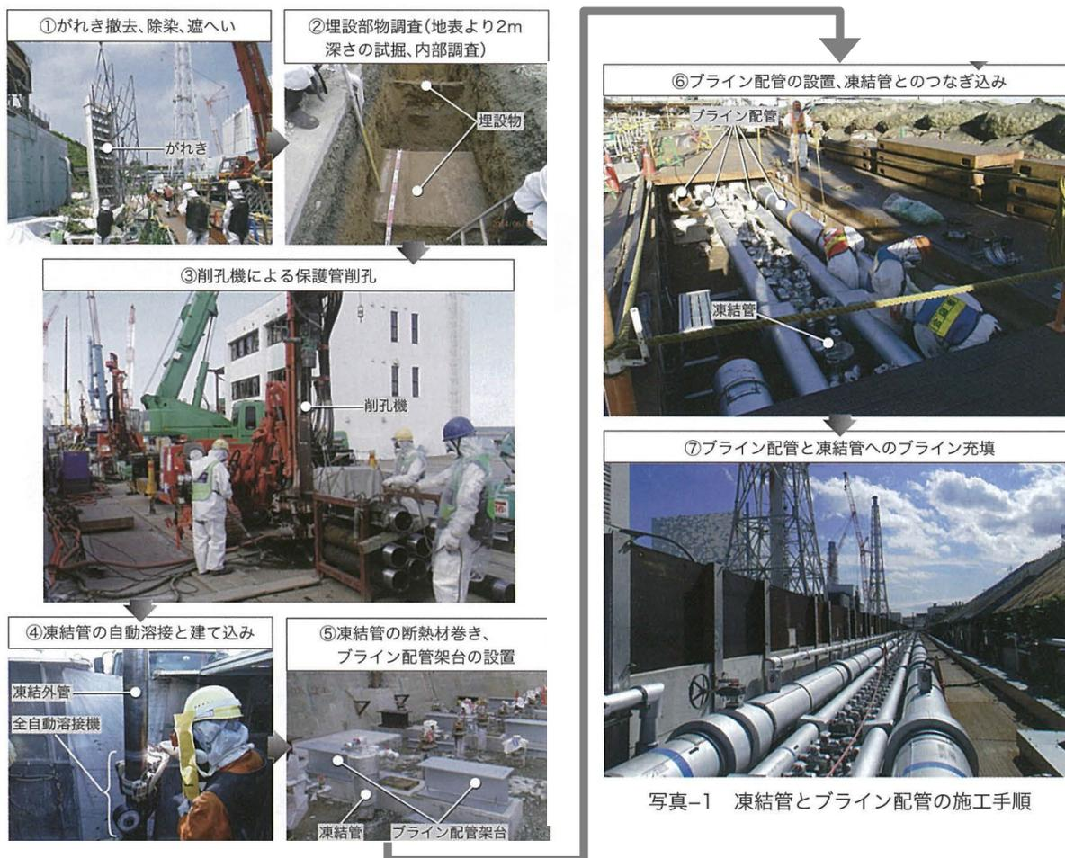
写真-1 凍結管とブライン配管の施工手順
