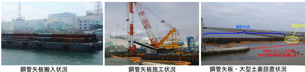
図 2-20 鋼管矢板及び大型土嚢の施工・設置状況 <sup>14)</sup>より引用
