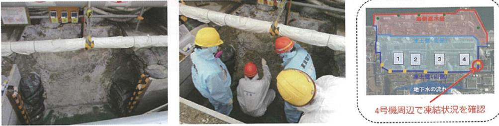
図 3-71 凍結状況（掘削調査，2018年3月15日）38)より引用
