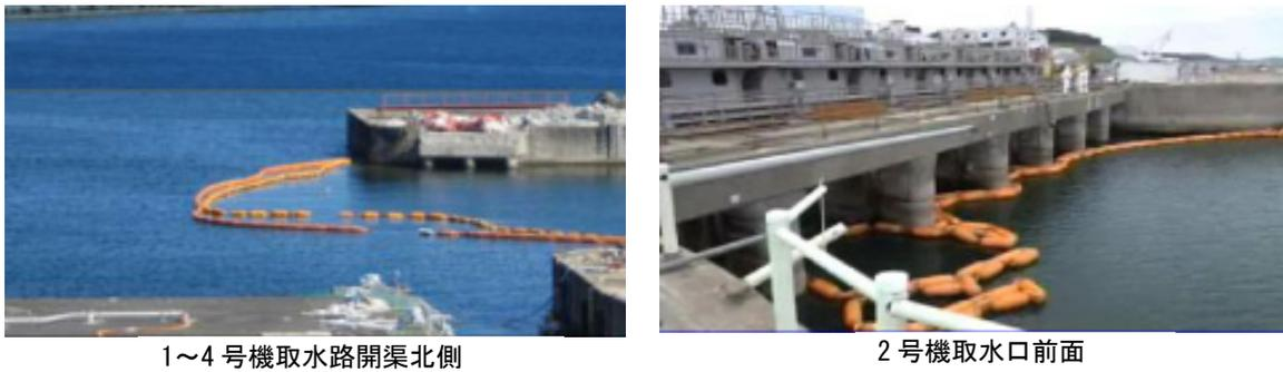
図 2-19 シルトフェンス設置状況 <sup>14)</sup>より引用
