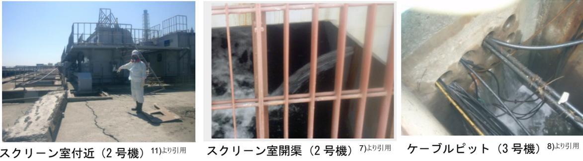
図 2-6 高濃度汚染水の流出状況
