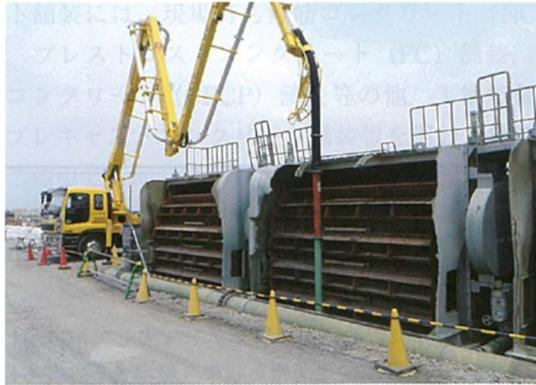
図 3-35 スクリーンポンプ室へのコンクリート打設状況 <sup>6)</sup>より引用
