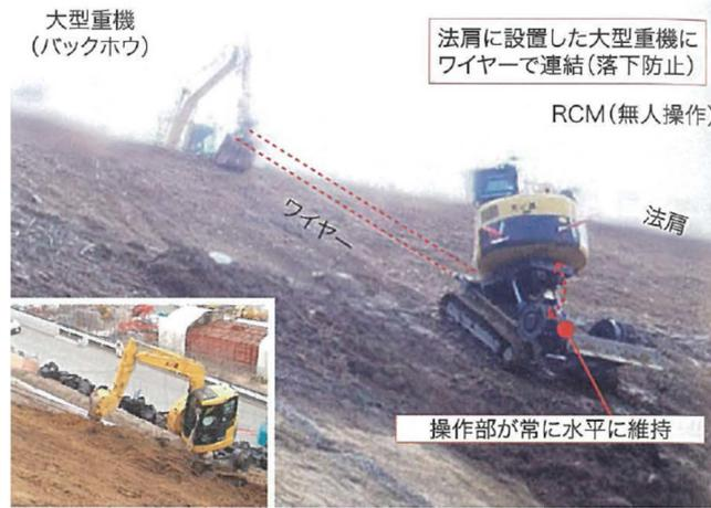
図 3-89 RCM による施工状況 5)より引用
