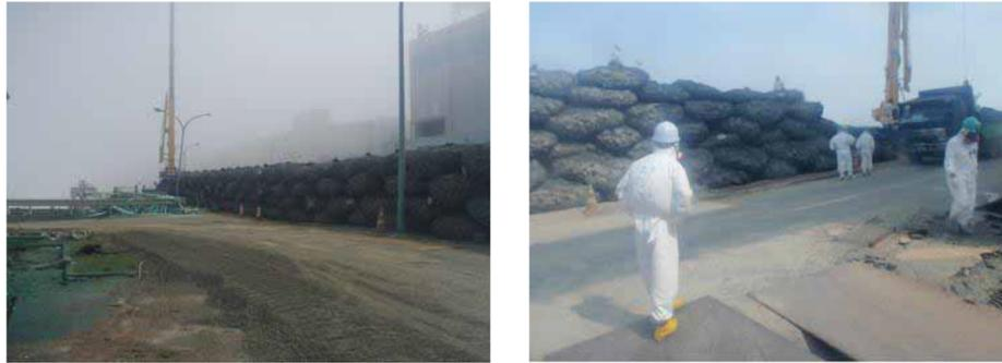
図 2-33 仮設防潮堤の施工状況 26)より引用
