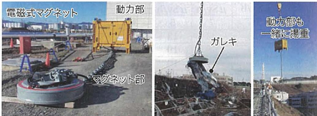
図 3-90 がれき撤去装置と施工状況 5)より引用
