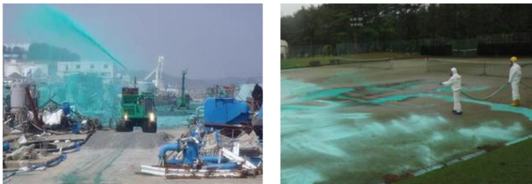
図 2-27 飛散防止剤の散布状況 2)より引用
