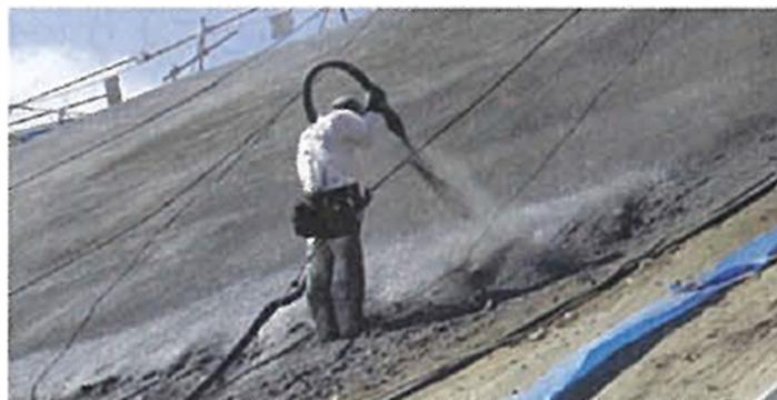
図 3-91 吹付けの施工状況 (人力施工) 5)より引用
